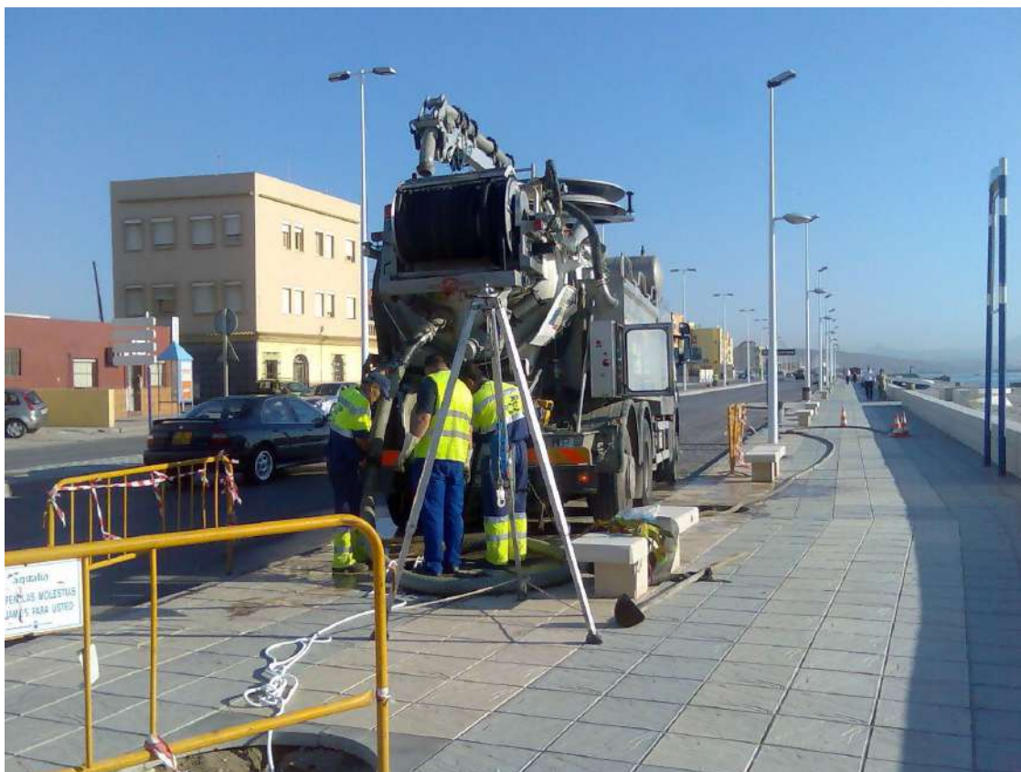
Trabajadores de Aqualia en una obra.
